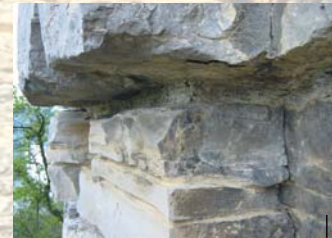
Weiche Mergelschichten verwittern schneller, es bilden sich Schichtfugen
